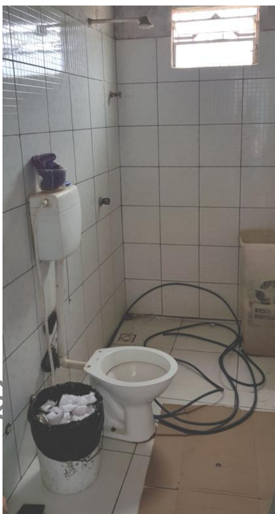
Figura 20: Banheiro utilizado pelos cooperados.
