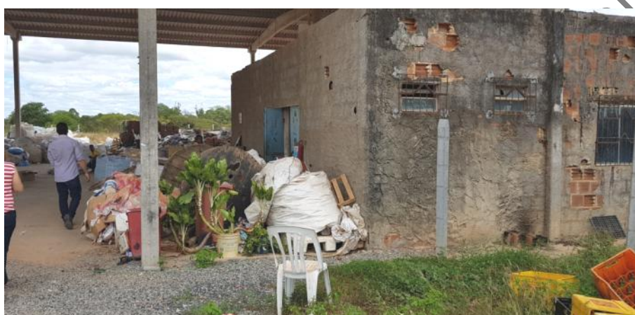
Figura 18: Precariedade do barracão.
